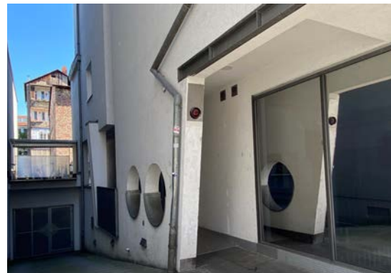
Eingangsbereich mit Zufahrt TG
